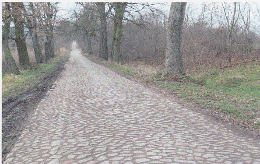
Zdjęcie nr 1 Nawierzchnia brukowcowa
