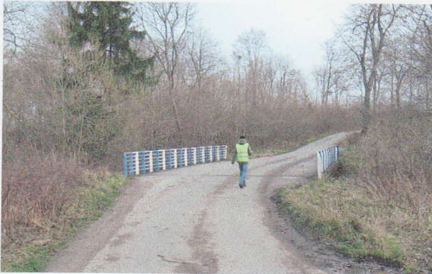
Zdjęcie nr 4 Most żelbetowy
