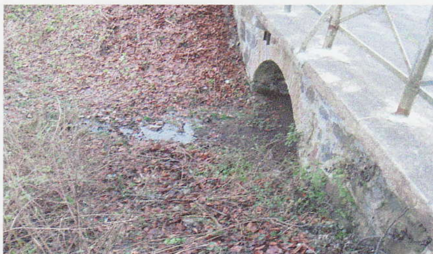
Zdjęcie nr 3 Przepust łukowy
