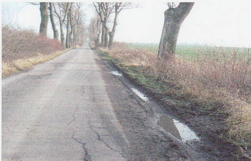
Zdjęcie nr 2 Nawierzchnia bitumiczna
