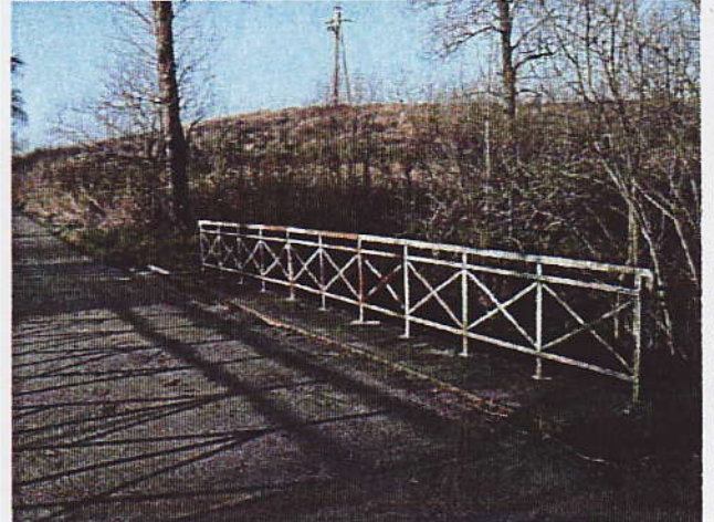
Widok na wylot
