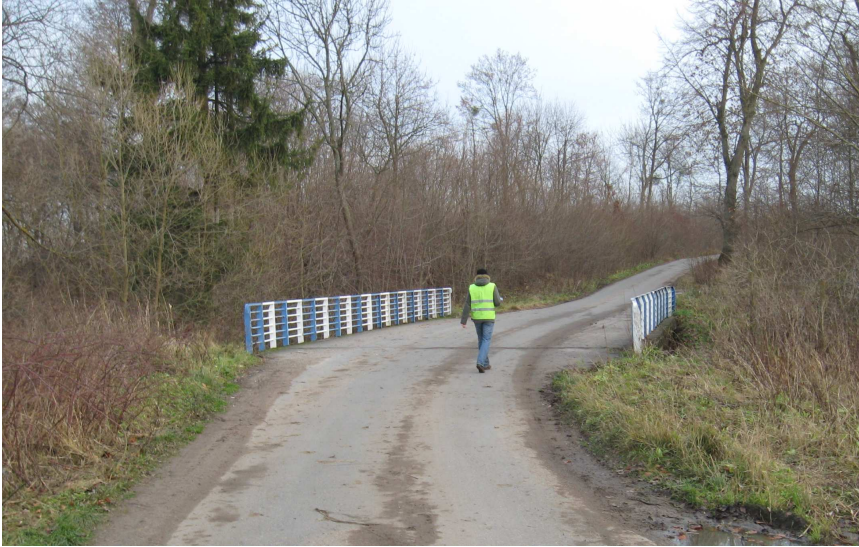
Zdjęcie nr 4 Most żelbetowy
