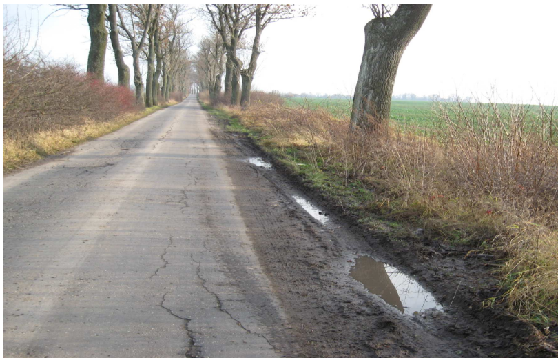
Zdjęcie nr 2 Nawierzchnia bitumiczna
