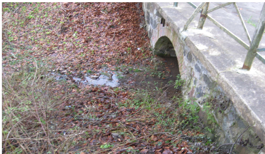
Zdjęcie nr 3 Przepust łukowy
