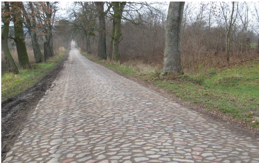
Zdjęcie nr 1 Nawierzchnia brukowcowa
