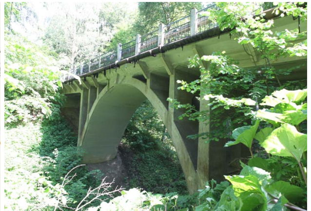
Widok ogólny od strony dolnej wody.
