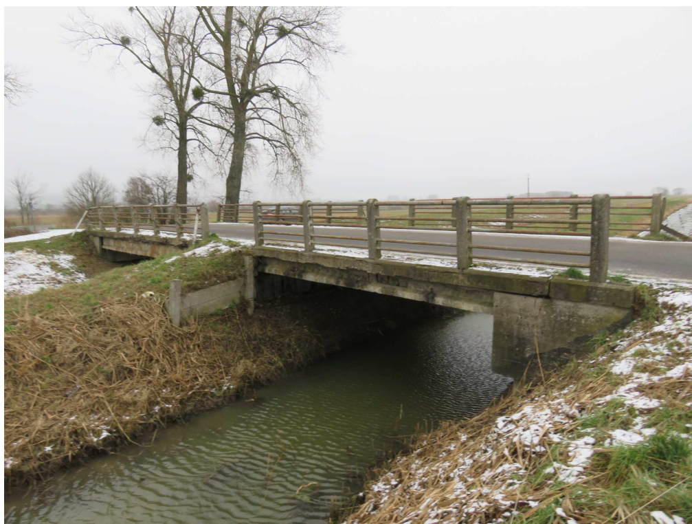
Fot. 1 widok ogólny mostu od strony dolnej wody
