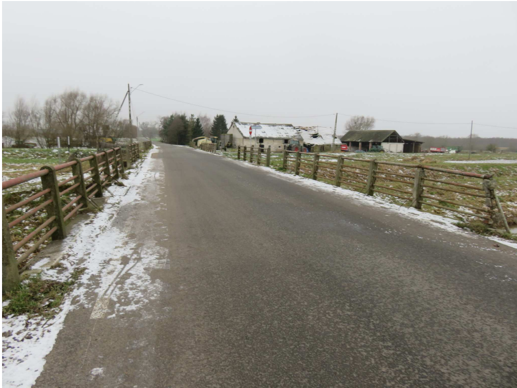
Fot. 2 widok ogólny na nawierzchnię
