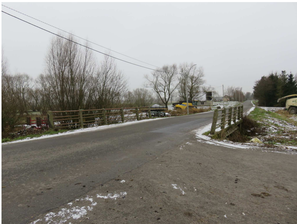
Fot. 2 widok ogólny na nawierzchnię
