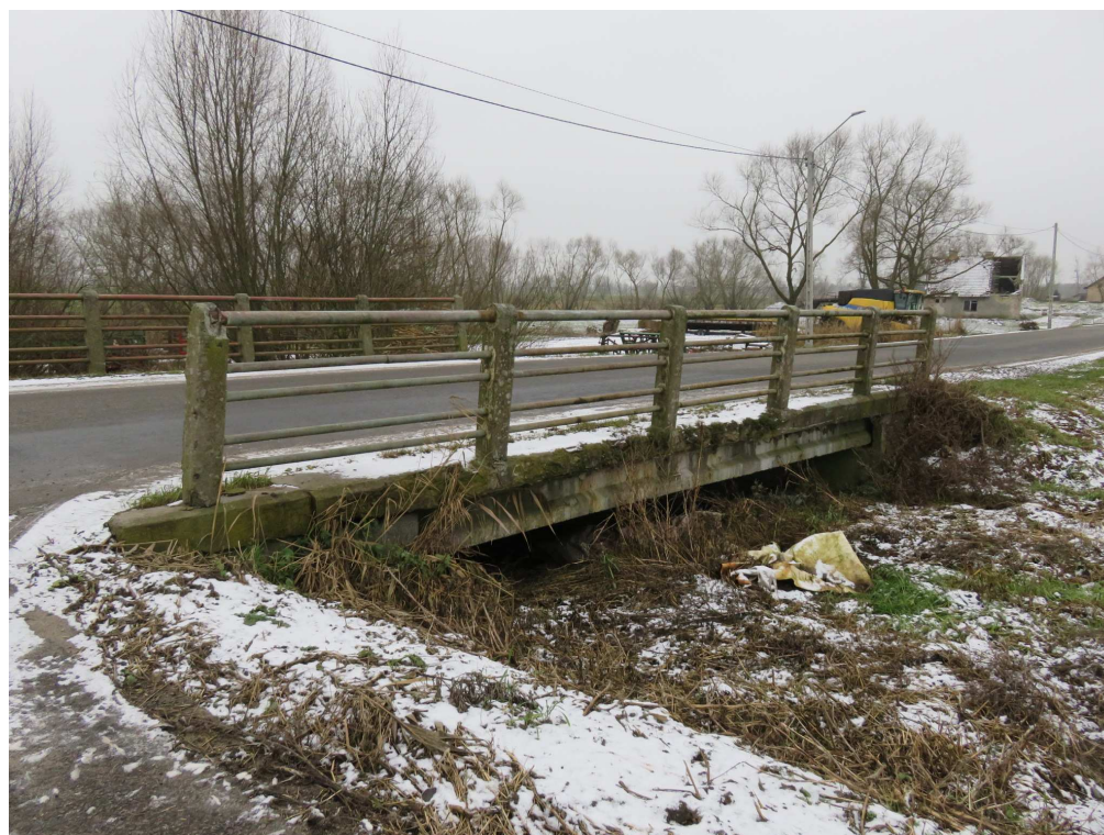
Fot. 1 widok ogólny mostu od strony zachodniej
