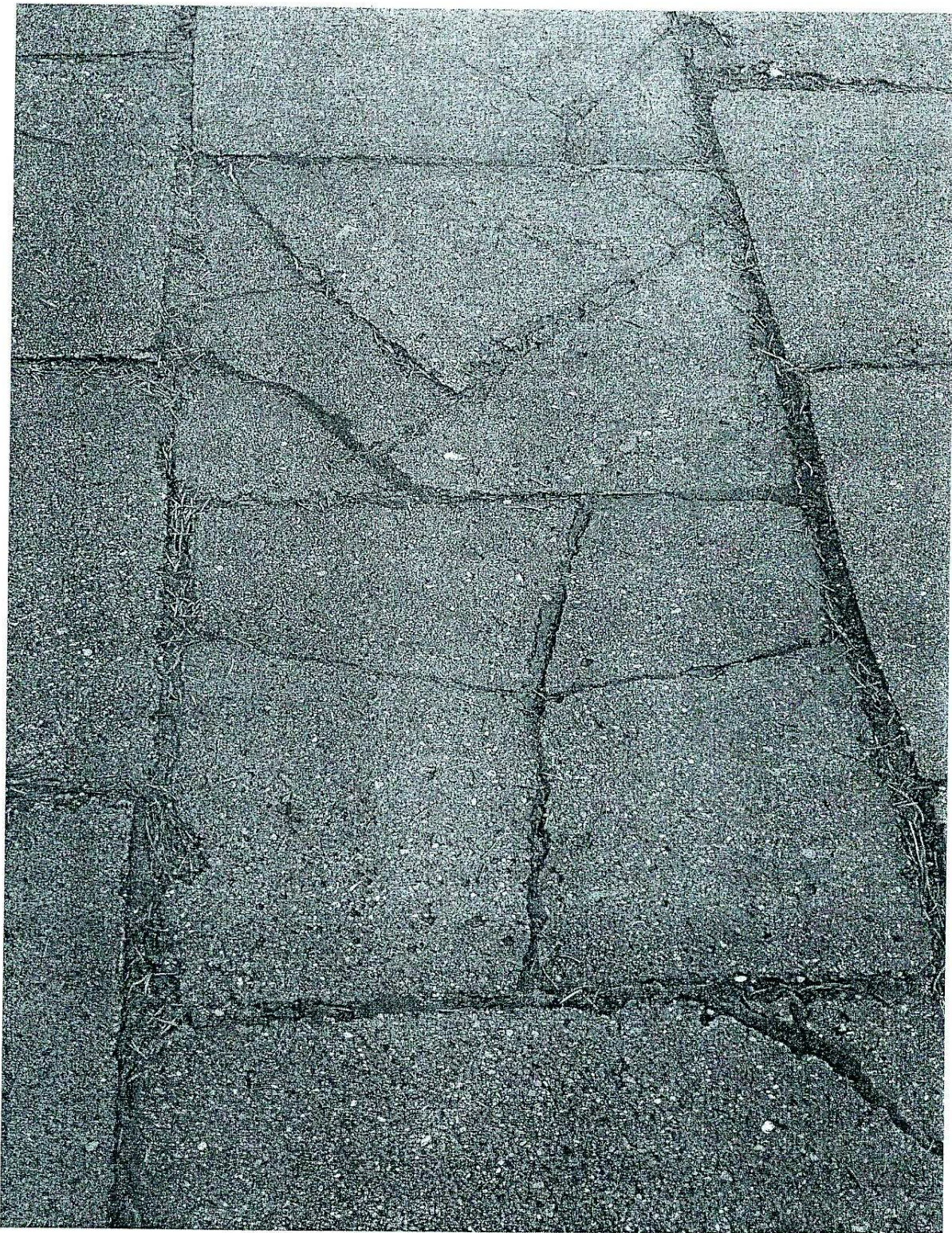
10. Chodnik przy ul. Paderewskiego
