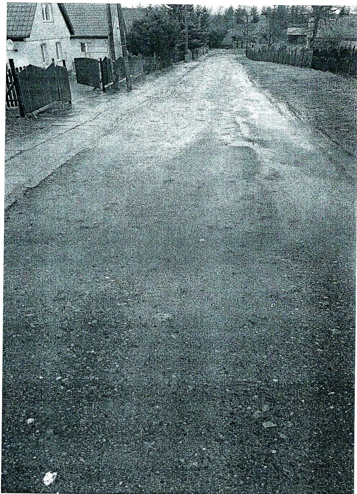
12 ul. Chopina w Pasłęku z tworzącymi się lejami po opadach deszczu
