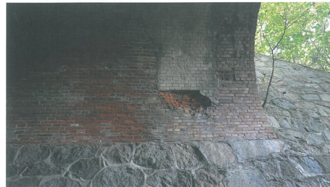
Cementowe uzupełnienie wewnątrz łuku
