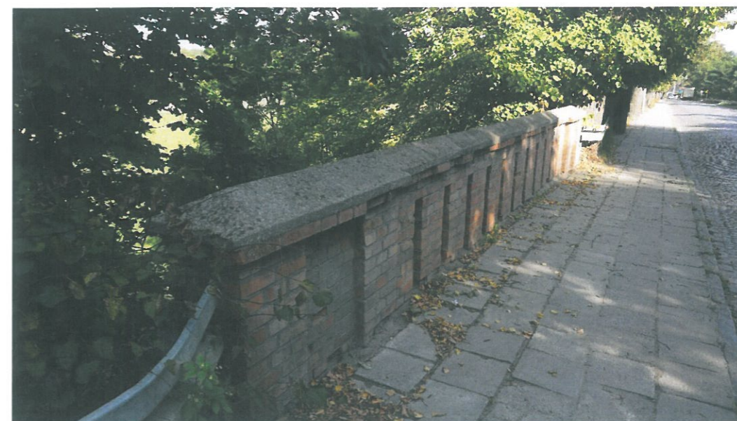
Balustrada od strony jezdni
