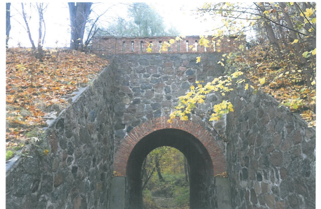
Widok na arkadę, ściany skrzydeł
